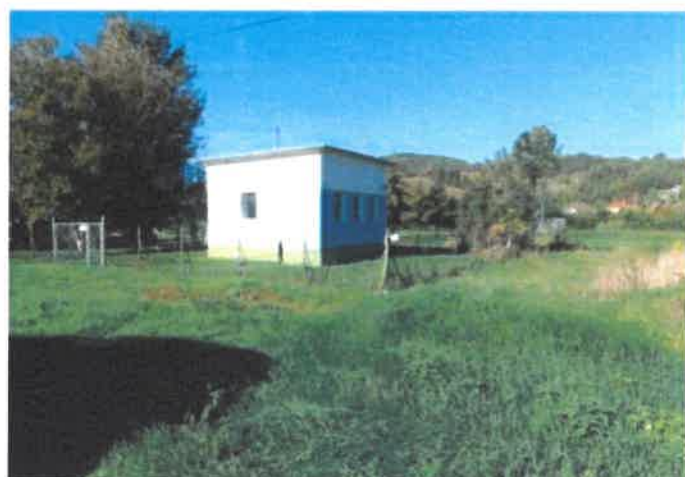
Nem értékelt szomszédos vízmű 0178/1 Hrsz
